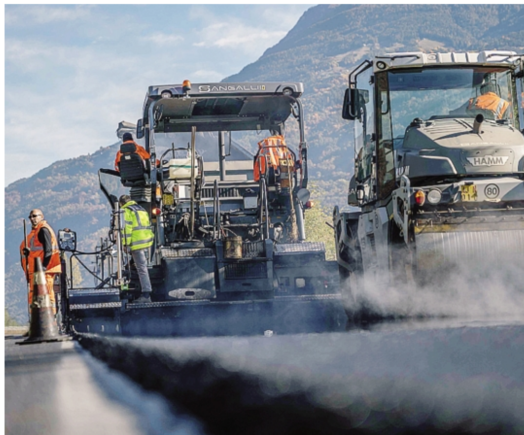
Una squadra Sangalli all'opera sul fronte della manutenzione stradale: l'azienda ha più di cento addetti
